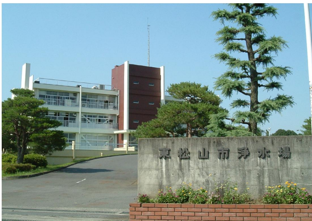
耐震補強工事の完了した水道庁舎
