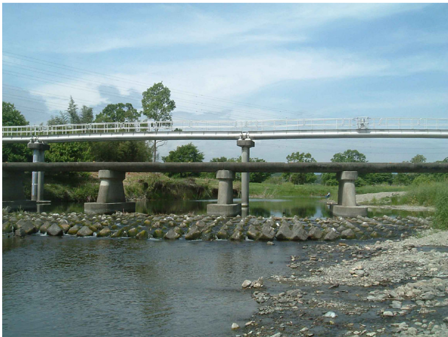
新しい管に架け替えられた稲荷水管橋（下唐子）
