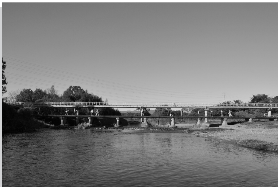
都幾川に架かる稲荷橋と水管橋
