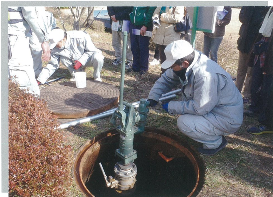
松風公園の緊急貯水槽から手動式ポンプにより水をくみ上げている様子。 【高坂丘陵地区応急給水拠点見学会】
