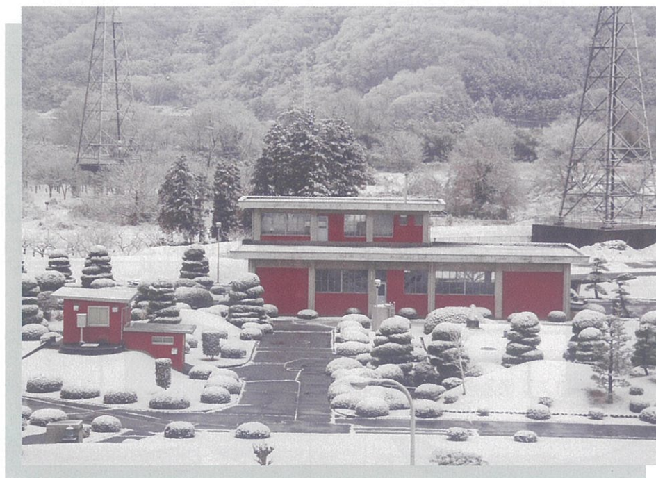
雪の第一浄水場 (平成28年1月撮影)
